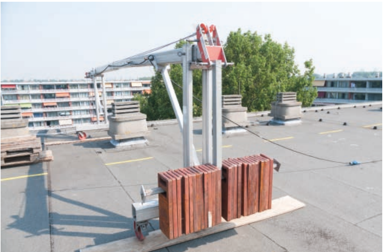
Foto 1: De ophangconstructie is een evenwichtsconstructie
